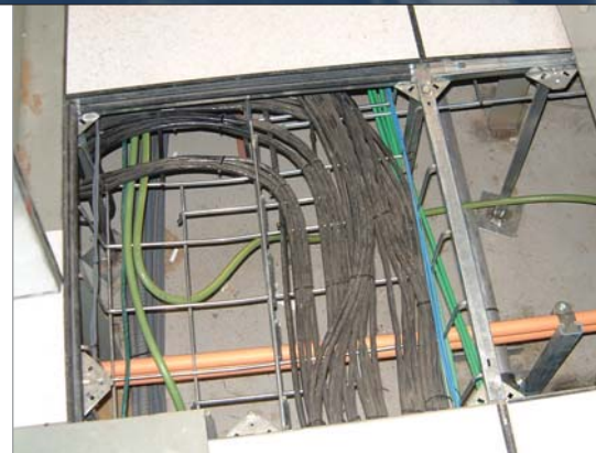
Instalación bajo el suelo
